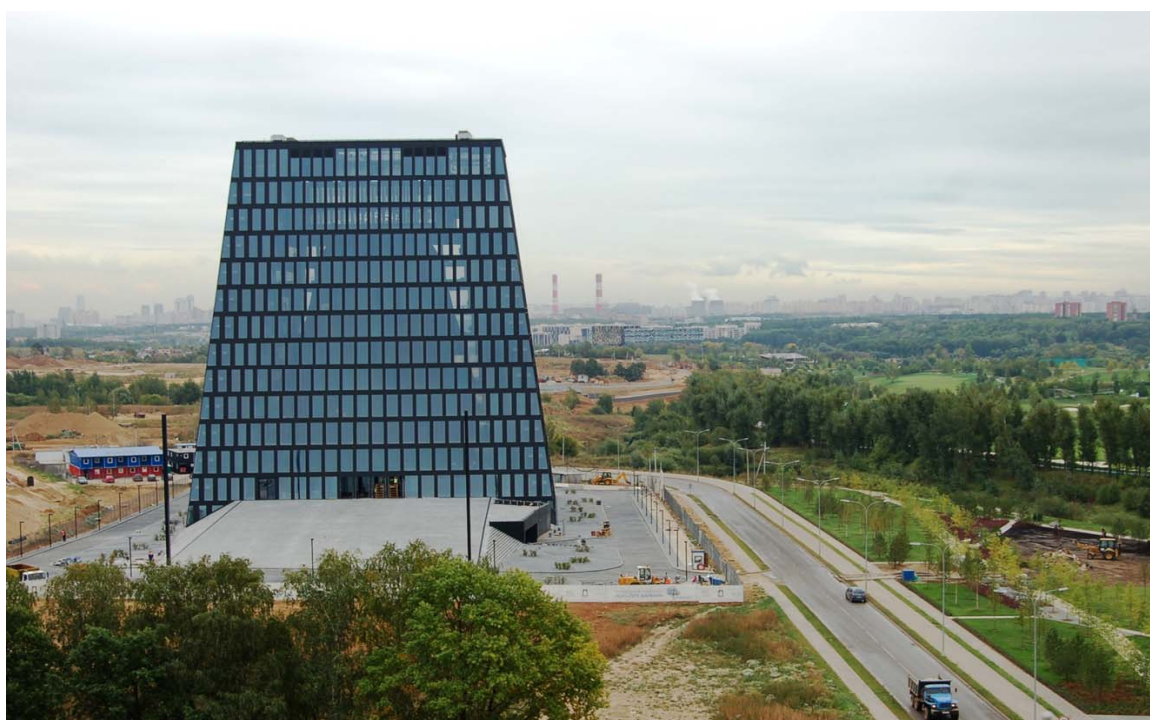
Деловой центр в Сколково "Матрешка" (внешний вид здания)
