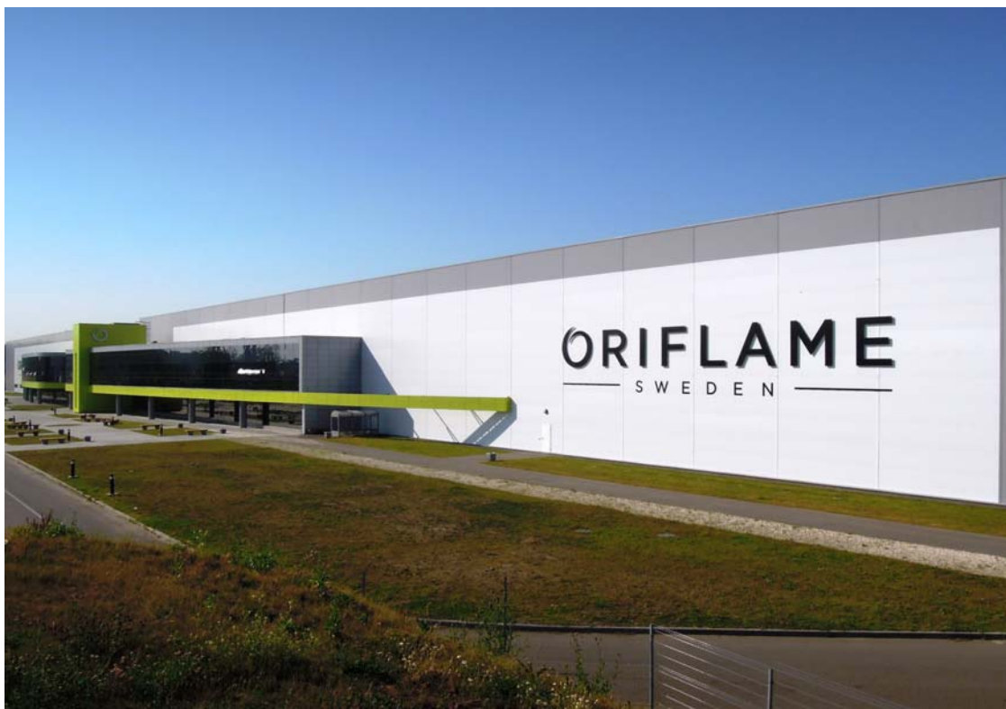
Производственно-Логистический центр "Орифлейм"(внешний вид здания)
